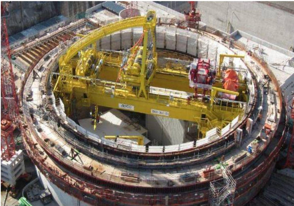
Vue de la machine (pont polaire et chariot en jaune): les deux chariots provisoires sont en rouge © DR
