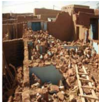
Démolition d'une maison radiologiquement contaminée
