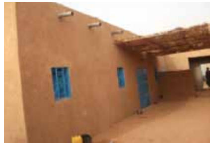
Reconstruction de la même maison avec des matériaux saints
